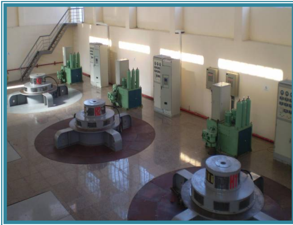
Tuabin Nhà máy thủy điện Iagrai 3
