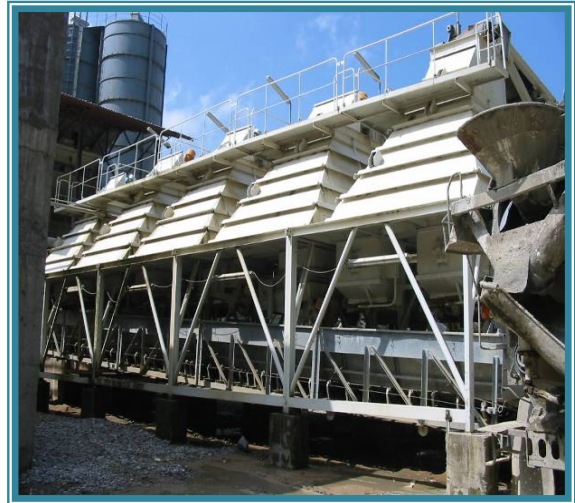
Trạm lạnh sản xuất bê tông
