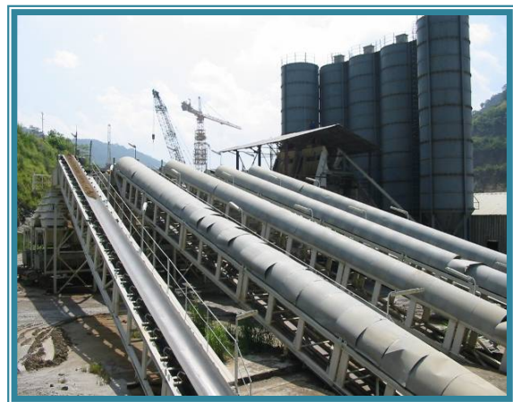
Xi lô trạm trộn bê tông
