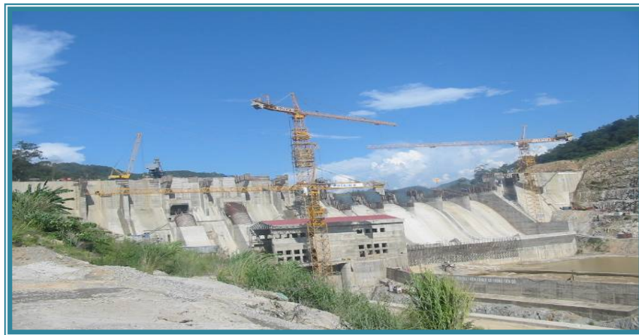
Công trình thủy điện Sê san 3
